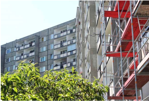
Fig. 2 Façade with loggias.
